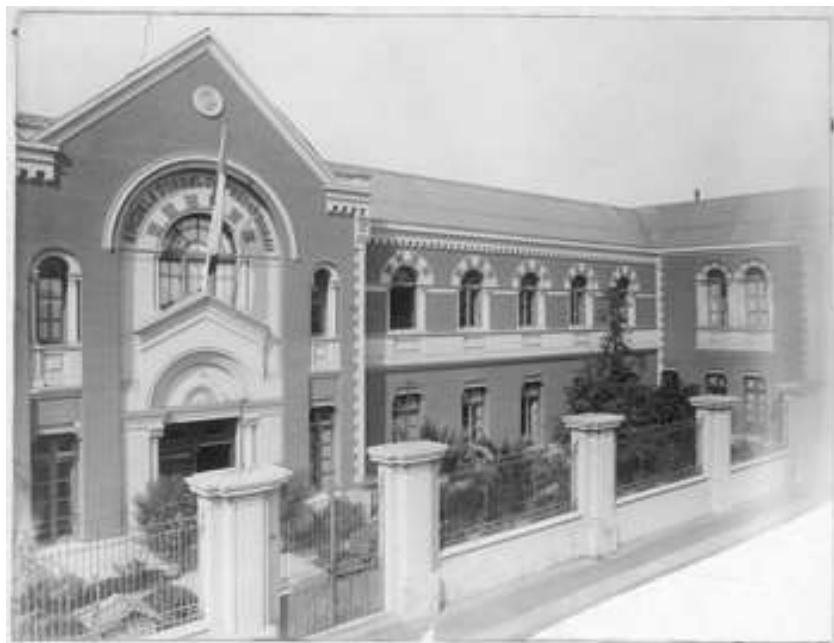
Edificio de la Escuela Normal de Preceptoras. Lugar donde Gabriela Mistral recibió el título de Maestra.
